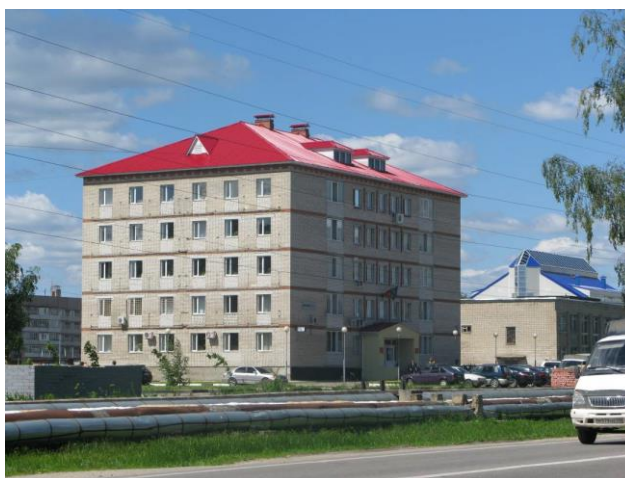
Здание администрации городского округа Электрогорск.
