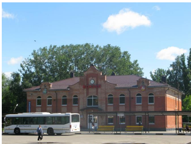
Здание железнодорожного вокзала и автовокзала (после реконструкции).
