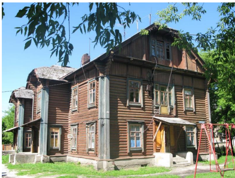
Жилой дом по ул. Ленина
